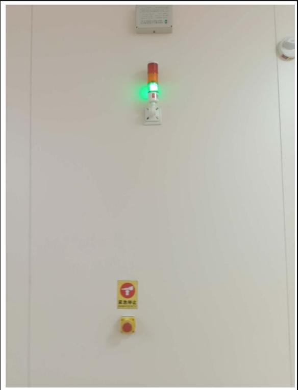
机房内急停开关、剂量仪探头
