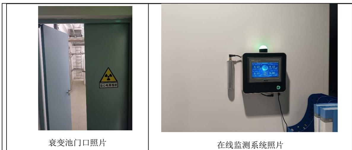
图 3-9 本项目衰变池和在线监测系统设置图
